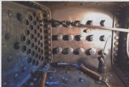
Bilder 8 und 9: Das Einwalzen der neuen Siederohre konnte bei liegendem Kessel in bequemer Arbeitsstellung erfolgen.
