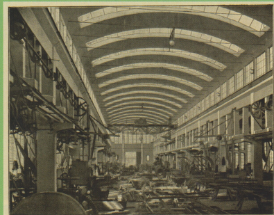
Abbildung Dr. 45. Innenansicht der Internationalen Däumafabrik Neustadt a. d. Elbe.
