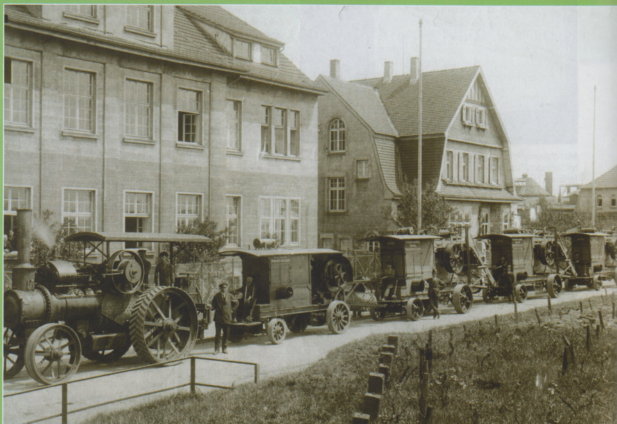
Neue Straßenlokomotive mit Funkenfänger und vier Selbstfahrer-Steinbrecher mit Verbrennungsmotoren.
