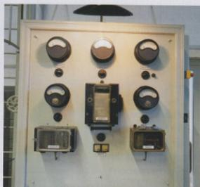
Anzeigetafel der Temperaturen und Drücke der drei Maschinen, sowie registriertem Netzdruck, Kesseltemperatur und Dampfdruck
