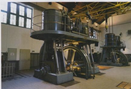
Gesamtansicht der beiden linken Maschinen, vorn die von der Firma Thyssen und Co aus Mülheim an der Ruhr, Verbundmaschine, gut sichtbar an den unterschiedlichen Baugrößen der Zylinder. Hoch oben darüber der Montagekran auf Wandschienen. Dahinter die Maschine aus Stuttgart
