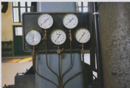
Maschinenarmaturen: oben links, Anzeige der Förderhöhe des Wassers; rechts daneben Vakuummeter des Kondensators, Anzeige ebenfalls in Meter Wasserhöhe.
