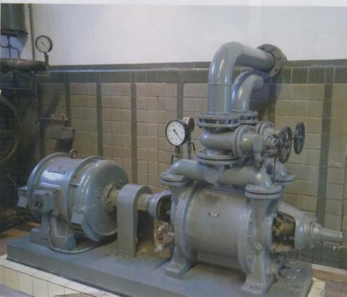
◀ Elektrische Hochdruckwasserpumpe zur Vorförderung bei Maschinenaussfall, um das Trinkwasser auf das benötigte Förderungs-niveau anzuheben
