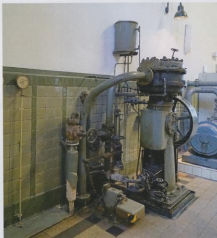
Eine der beiden Vorförderungs-niveau-Pumpen mit Dampf- statt Elektroantrieb für die beiden anderen Hauptdampfmaschinen
