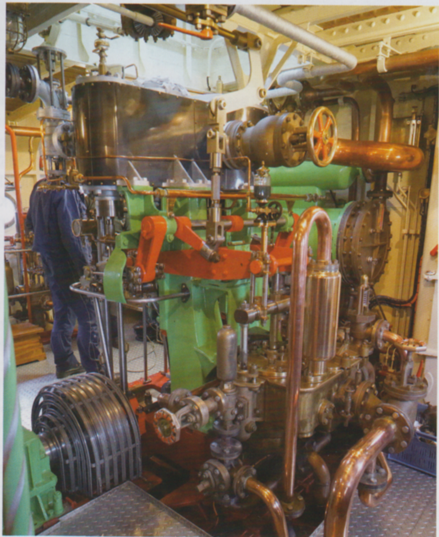
Dampfantrieb per Crabtree-Verbundmaschine; Kondensatorseite, Umsteuerung rot, Kupfer Abdampfrohr oben rechts, darunter Kondensator, dahinter von Lloyds gefordertes Fluchttor, links unter Gitter die Antriebstrennung und Schwingungsdämpfung
