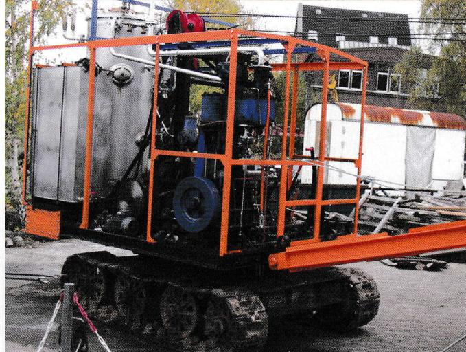
Einbau des fertigen Kessels und des Wassertanks von rechts, Oktober 2008.
